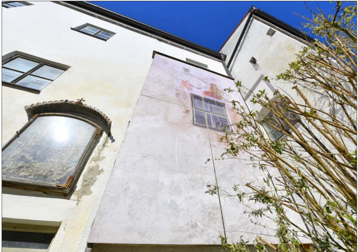
Ein Fresco, das fast zerstört wurde, ist hinter diesem Fotodruck auf einer Kunststoffplatte am Kastengegenschreiberturm versteckt. Dadurch soll es geschützt werden.
